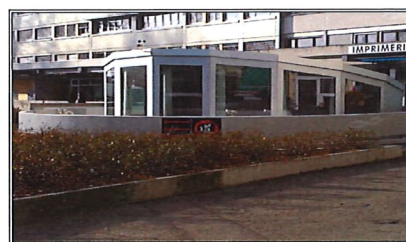
Immeuble 80 bis avenue des Communes-Réunies Local sport Construction FCIL
