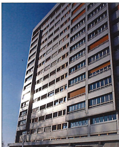
Immeubles 80, 82 et 84 avenue des Communes-Réunies 133 logements + surfaces commerciales – HLM-LUP Acquisition 2011
